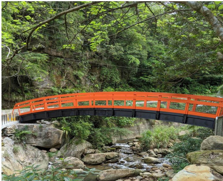
圖三十二 龍崗石壁坑農路人行橋
