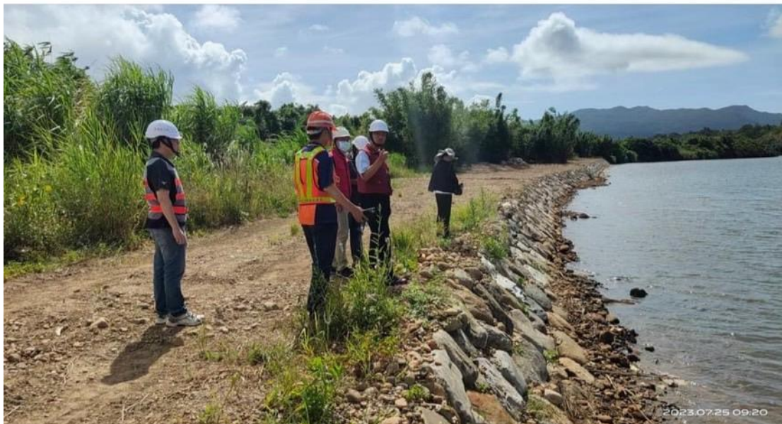
圖四十三 雙溪河砌石護岸
